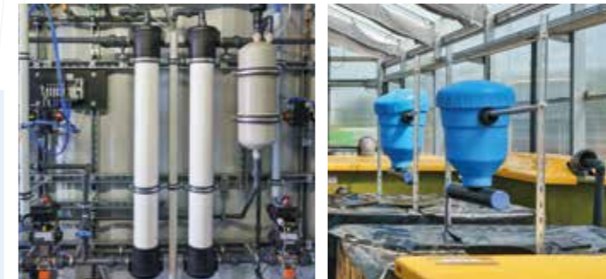
▲ Módulos de membrana de ultrafiltración (izquierda); tanques con sistema de alimentación automática para la acuaponía (derecha)
